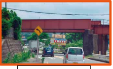
鉄橋下をくぐる
